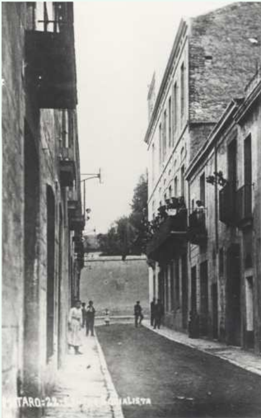
Casa del Poble de Mataró (1932). És l'edifici alt de la dreta. Museu Arxiu de Santa Maria (Mataró). Arxiu d'imatges
